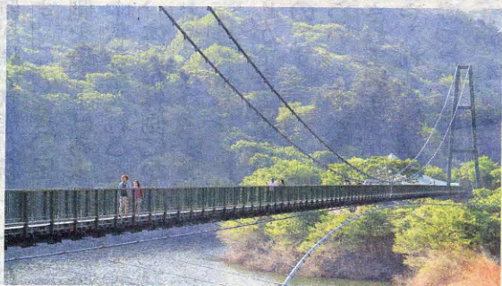
もみじ谷大吊橋
