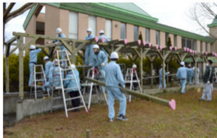
パーゴラを設置する宮津高の建築科3年生たち （京丹後市弥栄町・丹後あじわいの郷）
