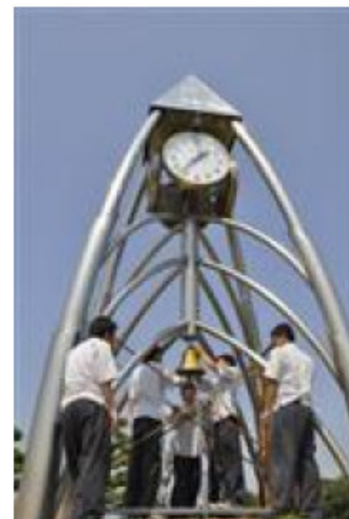
一の宮ドリームタワーの鐘を修理する三豊工高の生徒たち＝香川県観音寺市豊浜町
