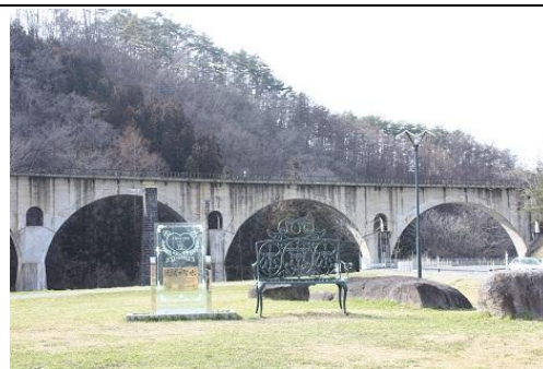
遠野市 宮守川橋梁／めがね橋
